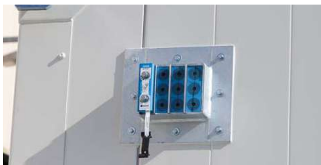
Boîte à câbles (cloison coupe-feu) pour le passage des câbles à travers la paroi de stockage coupe-feu tout en maintenant la résistance au feu de l'élément
